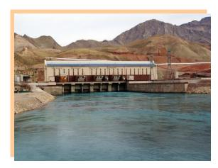
Здание ГЭС и отводящий канал: Общий 140,1х48,5м, габарит здания количество агрегатов - 4, размер агрегатного блока в плане 109,6х48,5м, мощность каждого 167,5MB<sub>T</sub>, обшая мощность гидроэлектростанции -670MB<sub>T</sub>, отводящий прямоугольного в ///планес канал сечения 89,5х62,0м.
