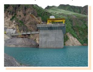
предназначенный для пропуска расходов воды в строительный и эксплуатационный период, размещен на правом борту долины и состоит из: напорного водоприемника, туннелей СЭВ и концевого участка СЭВ.
